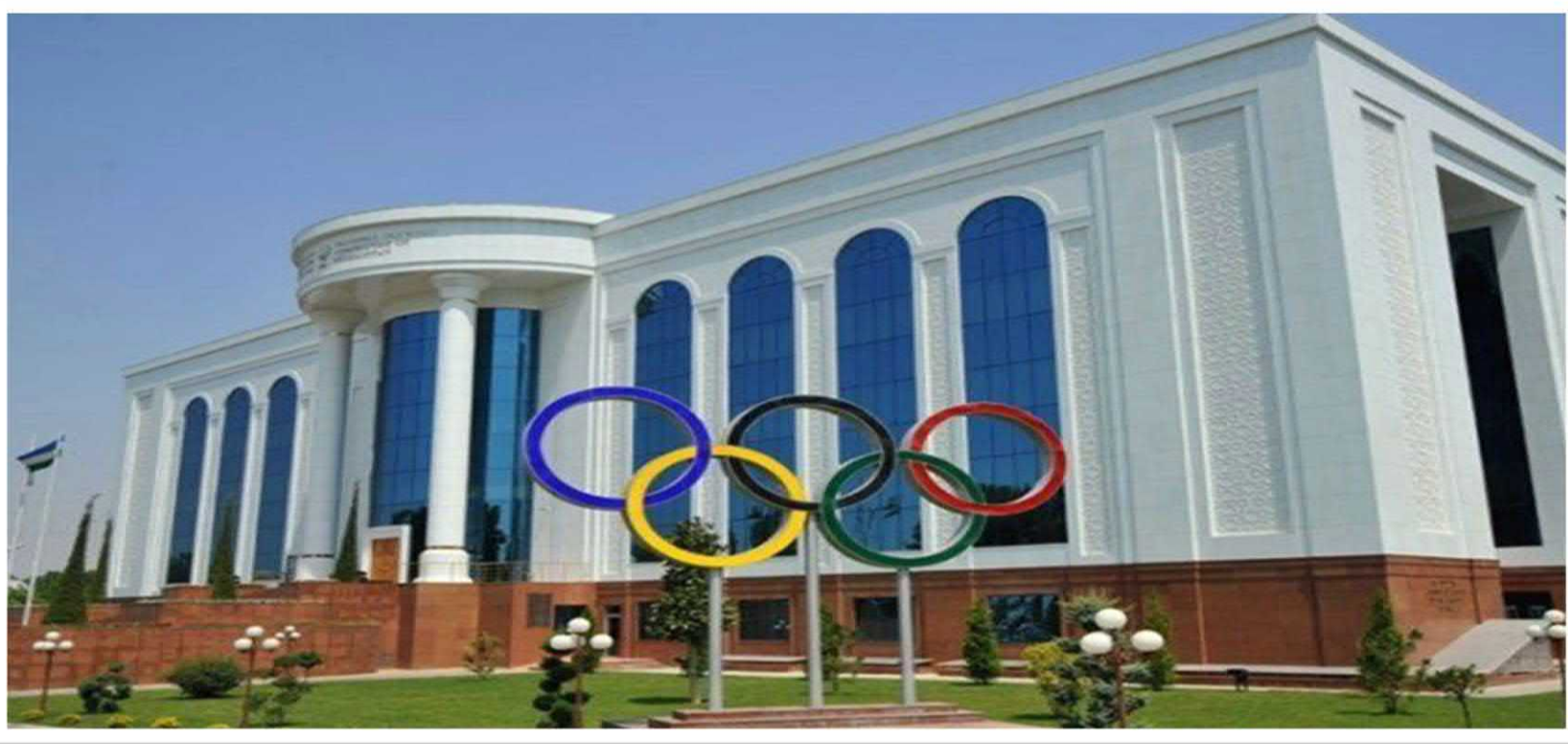
O‘ZBEKISTON MILLIY OLIMPIYA QO‘MITASI BINOSI (TOSHKENT)
