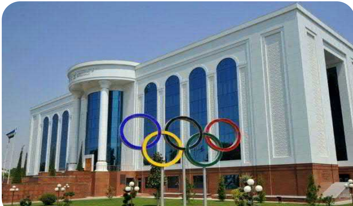
O‘ZBEKISTON MILLIY OLIMPIYA QO‘MITASI BINOSI (TOSHKENT)
